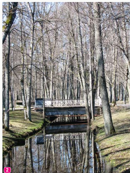
Мост через Вершупите
